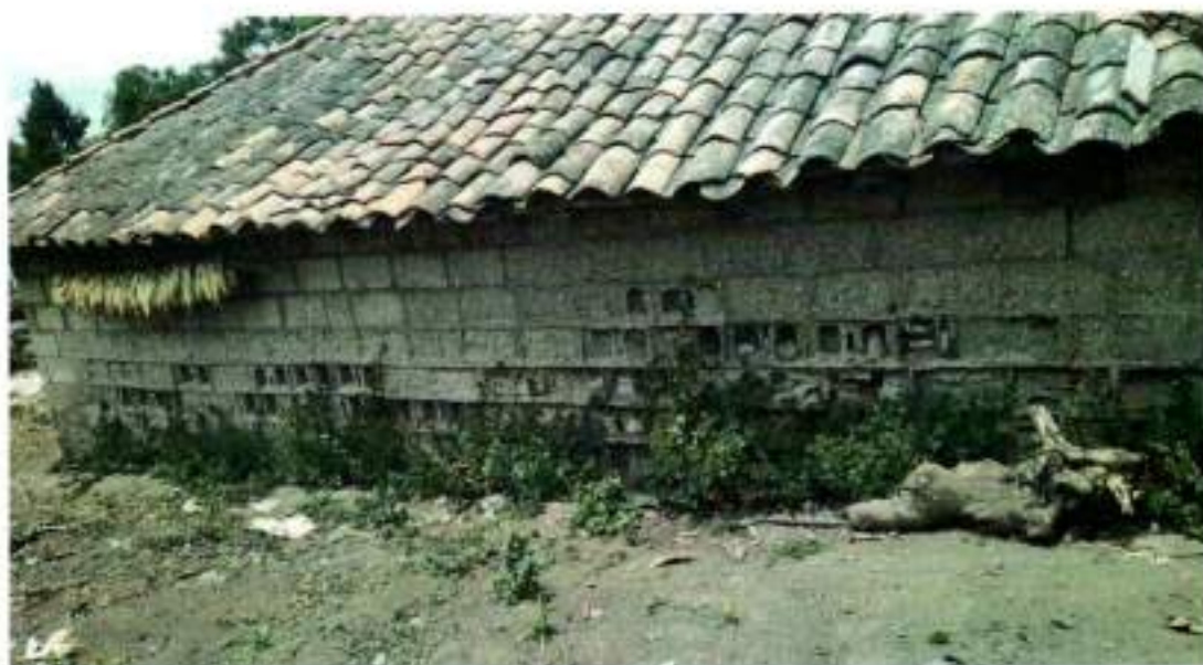
Fig. 6 Vivienda – Fachada posterior
