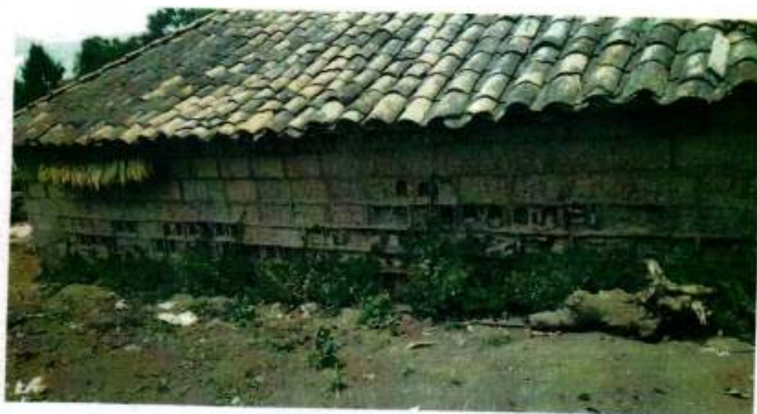
Fig. 6 Vivienda - Fachada posterior
